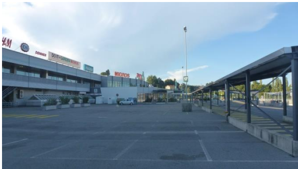
Vue depuis l'ouest sur l'entrée principale du centre commercial
