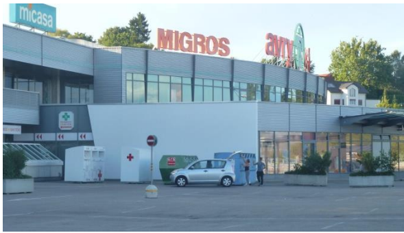
Figure 36 : Point de collecte existant
