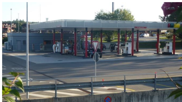
Vue depuis l'est sur la station-service
