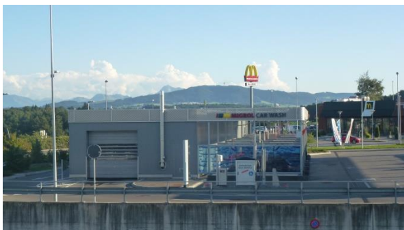
Vue depuis l'est sur la station de lavage existante Gibloux et Moléson en arrière-plan
