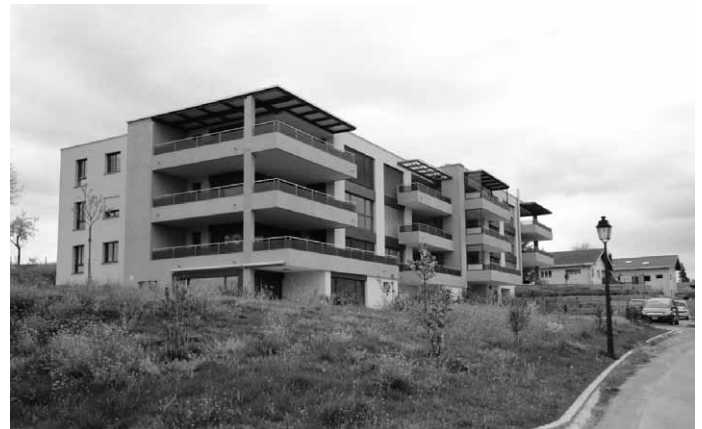
Immeubles de l'impasse des Agges 7 et 9
