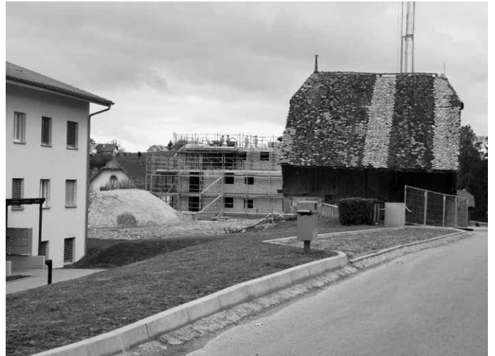
Dernier immeuble en construction près de la laiterie
